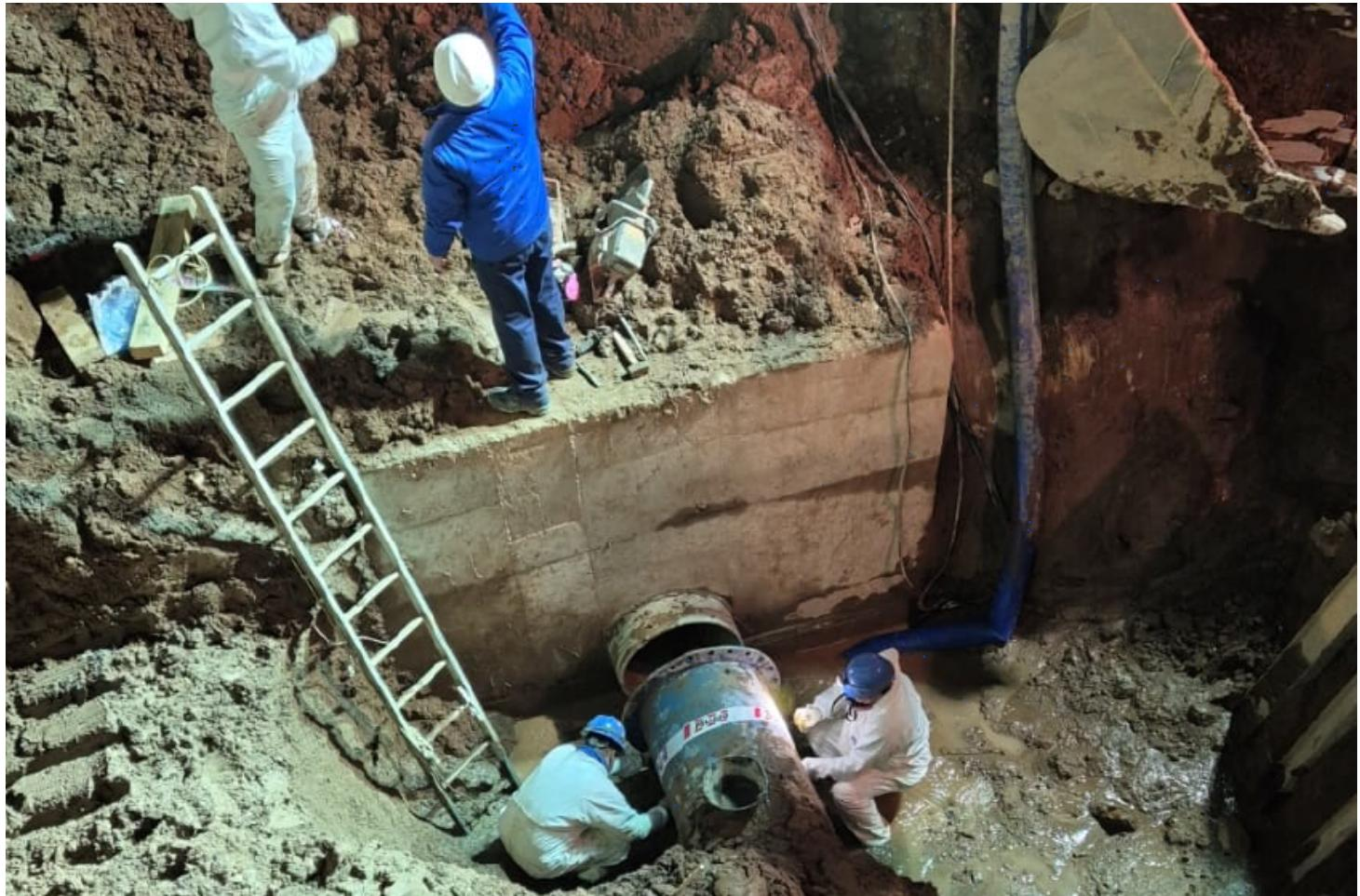
Les informamos que continuamos trabajando en la reparación de la pieza dañada: un ramal de 700 mm de diámetro nominal que deriva de un conducto de 1.800 mm de diámetro. Los equipos siguen abocados a la tarea para finalizar lo antes posible y poder restituir el servicio en la zona.
