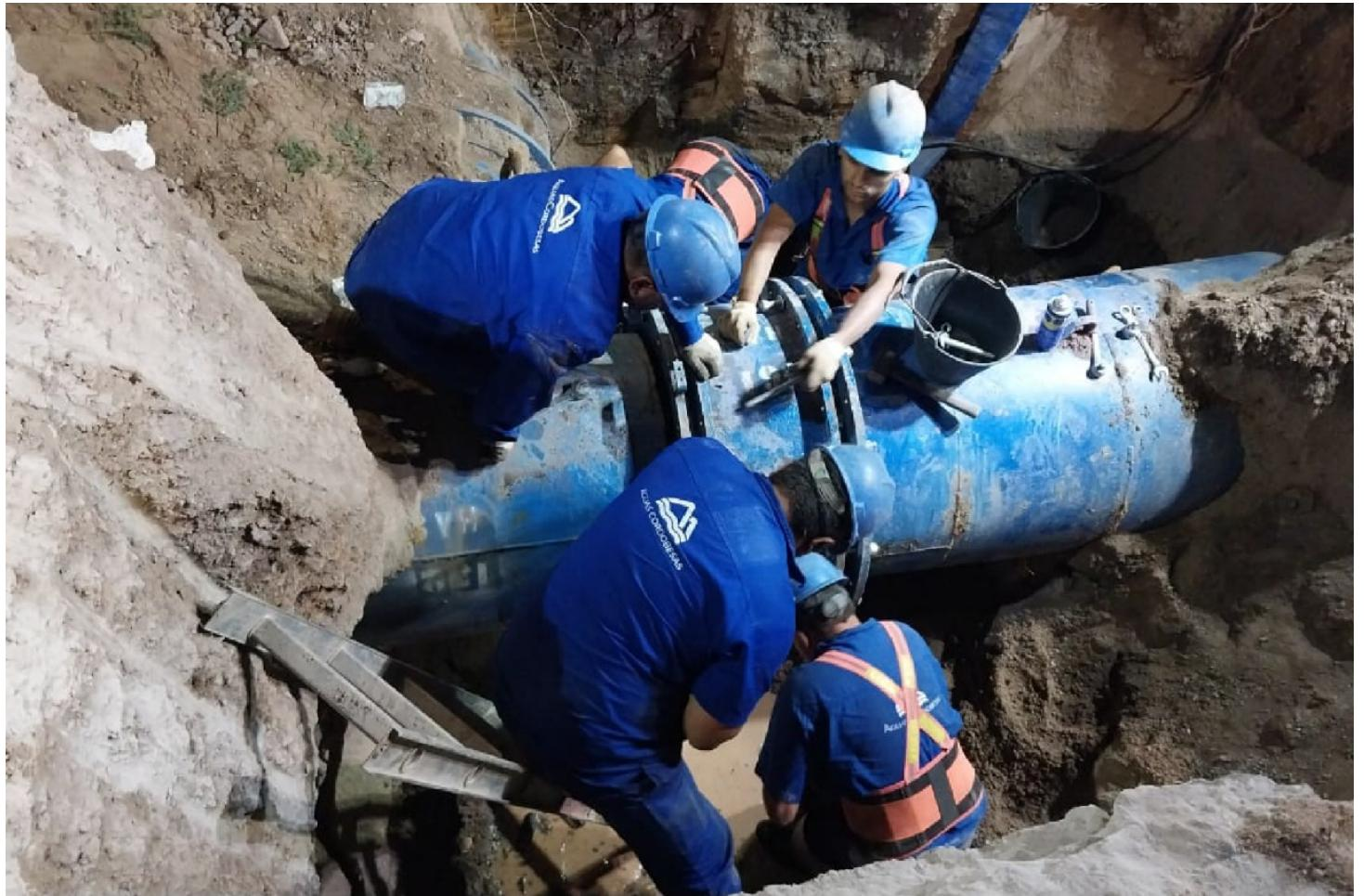
A raíz de la rotura del conducto en Achaval Rodriguez y Arturo M. Bas se trabajó toda la noche y se aisló el conducto colocando un tapón en José Artigas y Achaval Rodriguez. Esta acción nos permite restituir el servicio en la zona, mientras seguimos trabajando en la reparación del conducto de 700 mm en Achaval Rodriguez y Arturo M Bas.
